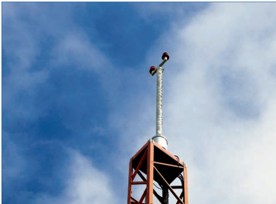
Slika 4: Naprava za merjenje razdalje (DME) na letališču Jožeta Pučnika je locirana na istem stebru kot naprava za določanje drsne poti (GP) (prejšnja slika).
