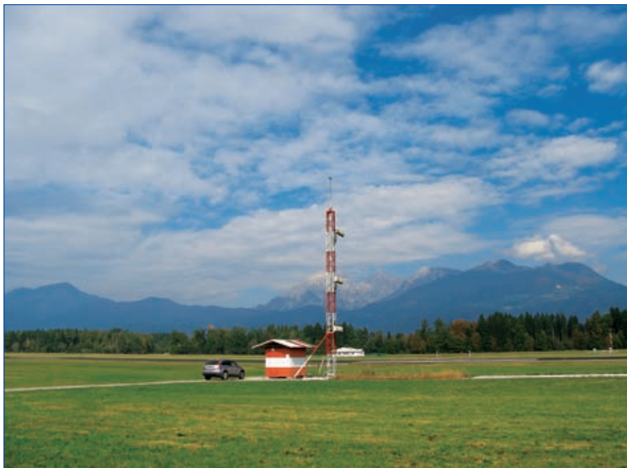
Slika 3: Oddajnik za določanje drsne poti (GP) na letališču Jožeta Pučnika. Nahaja se južno od vzletno-pristajalne steze. Na stolpu je na vrhu nameščena tudi antena naprave za merjenje razdalje (DME) ( naslednja stran ).
