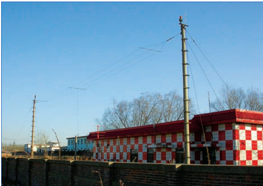
Slika 6: Neusmerjeni radijski svetilnik (NDB) z anteno, nameščeno na drogovih (slika: www.wikipedia.org ).
