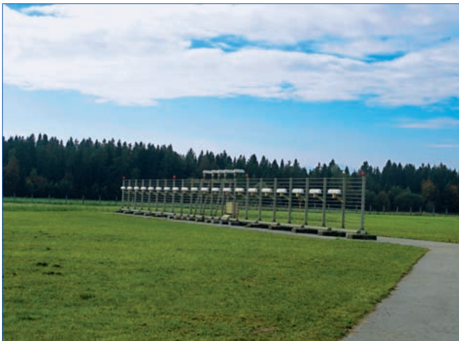
Slika 1: Oddajnik smeri (LLZ) na letališču Jožeta Pučnika. Nahaja se na zahodni strani vzletno-pristajalne steze.
