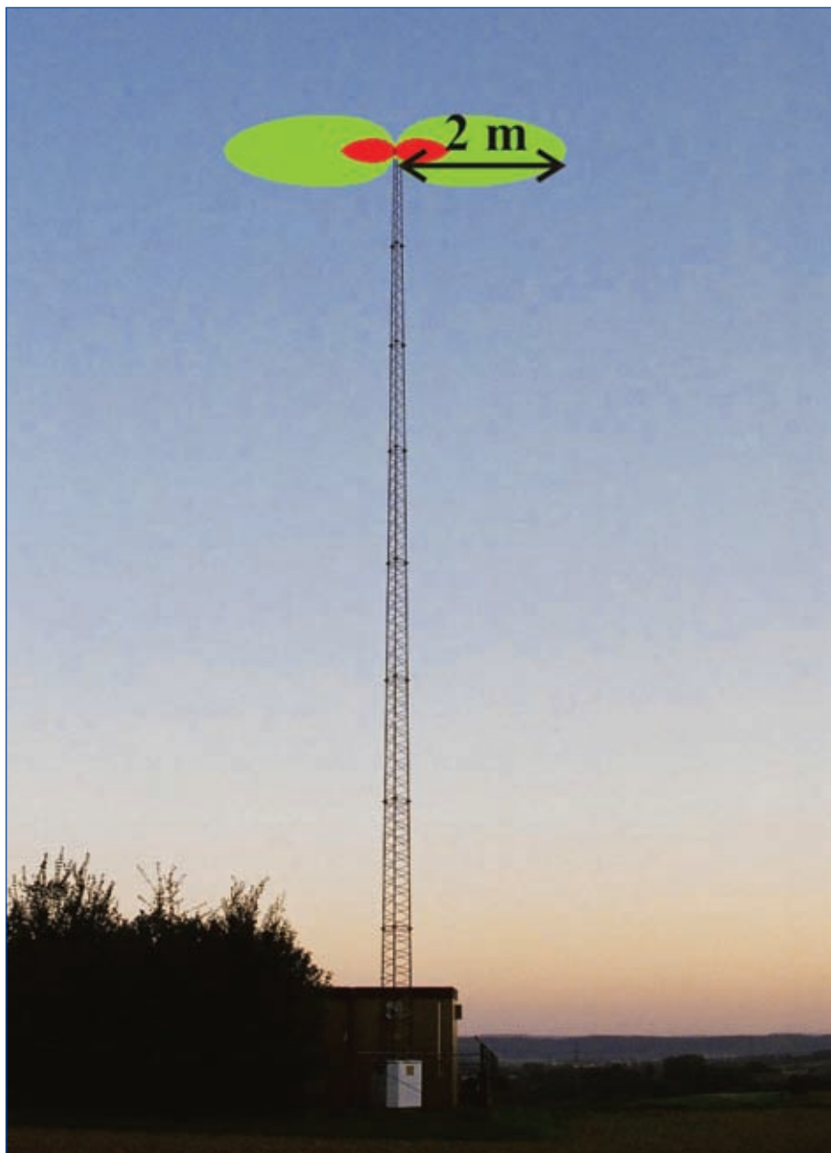
Slika 7: Efektivne vrednosti električne poljske jakosti v okolici neusmerjenega radijskega svetilnika v navpični ravnini skozi središče anten. Z rdečo barvo je prikazano vplivno območje za II. območje varstva pred sevanji, z zeleno pa za I. območje varstva pred sevanji (slika: www.wikipedia.org ).
