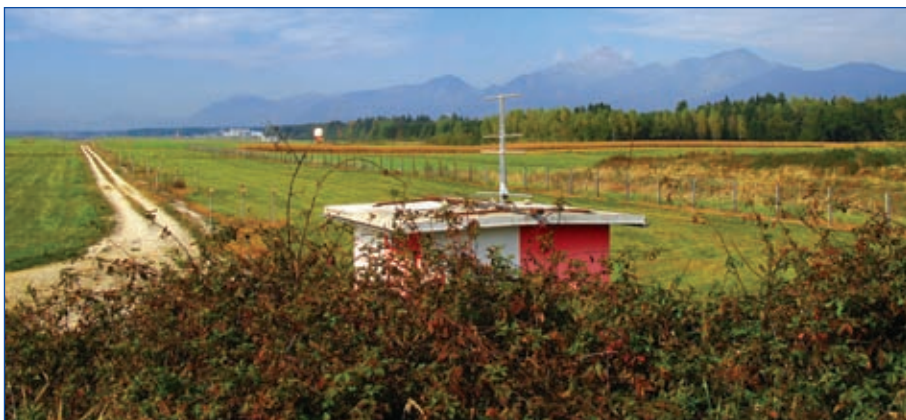
Slika 13: Oddajna antena označevalnika (MRK) na letališču Jožeta Pučnika, ki se nahaja vzhodno od vzletno-pristajalne steze.
