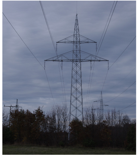
S3: Najpogostejša tipa stebrov dvosistemskega VN daljnovoda. Levo sod, desno donava.
