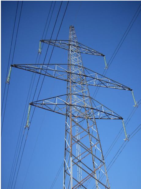
S3: Najpogostejša tipa stebrov dvosistemskega VN daljnovoda. Levo sod, desno donava.
